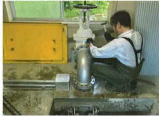
【村木 ポンプ修理】
