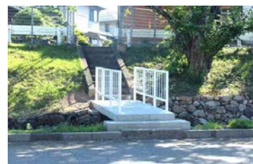
【改修した橋りょう】
