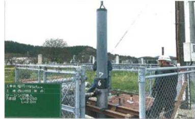
【西山 ケーシング管更新等】
