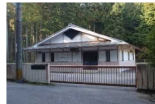
【公共下水道に接続予定の 山室地区農業集落排水処理場】
