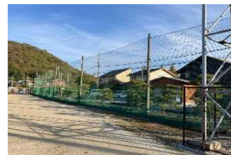
【近江グラウンド：防球フェンス設置】
