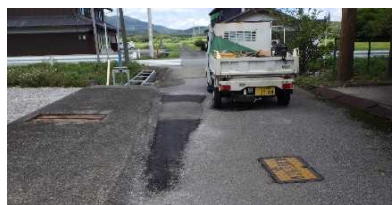
【市道等道路維持補修作業】
