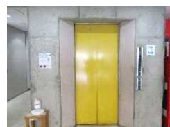
【エレベーター改修】
