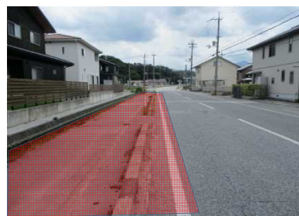
【市道顔戸能登瀬線道路改良工事】
