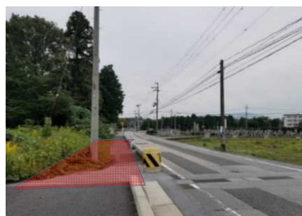
【市道板戸市場線道路改良工事】
