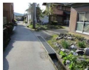
【野一色排水路】
