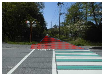
【市道市場橋本線道路改良工事】
