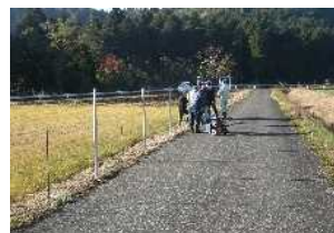
【侵入防止柵の整備】
