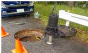
【マンホールポンプ更新】
