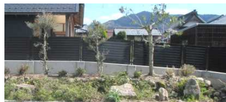
【柏原福祉交流センターに整備したフェンス】
