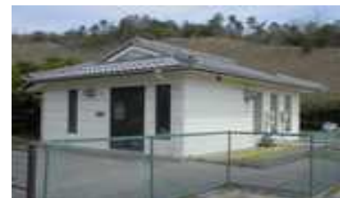
【菅江地区農業集落排水処理場】
