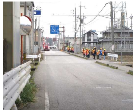
【顔戸国道線歩道整備工事】
