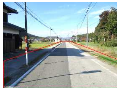
【板戸市場線道路改良工事】
