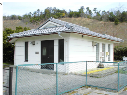
【菅江地区農業集落排水処理施設】
