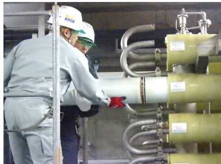
【本市場浄水場での RO膜交換の様子】
