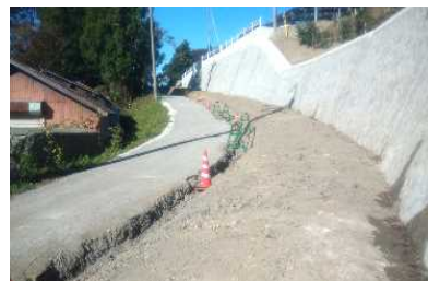
【藤川2号線道路改良工事】
