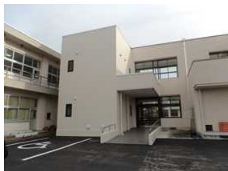
【平成30年度に完成したエレベーター棟（伊吹山中）】
