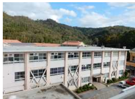
【長寿命化改良工事に着手する双葉中学校】
