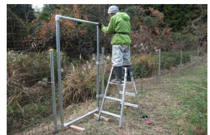
【侵入防止柵の整備】
