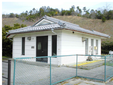
【菅江地区農業集落排水処理施
