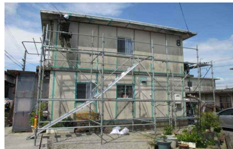
【改良住宅目地修繕工事】
