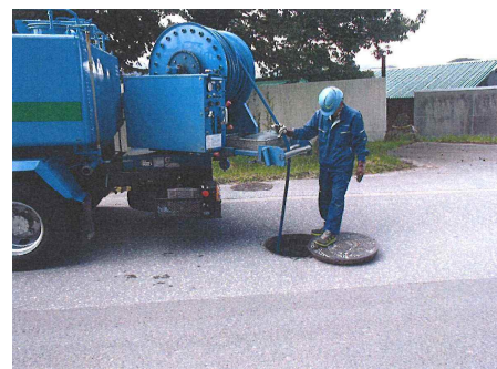
【汚水管内の高圧洗浄】
