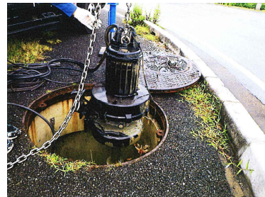
【マンホールポンプ更新】
