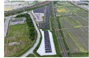
【梅ヶ原地先発電設備】
