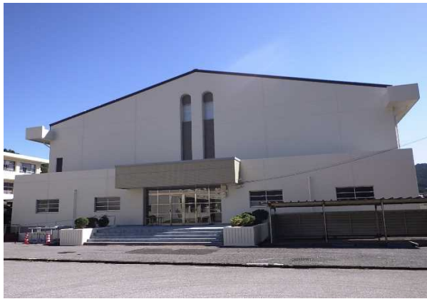
【防災機能を強化した柏原中学校体育館(入口)】
