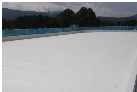
【防水処理を施した柏原小学校の屋上】
