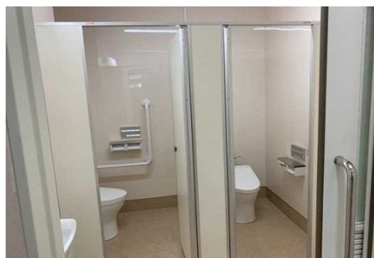
【改修した伊吹小学校職員用トイレ】
