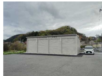
【長岡地先 防災備蓄倉庫】
