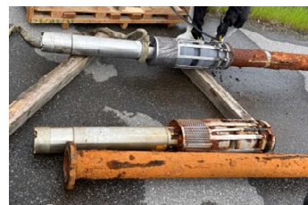
【消雪ポンプの交換】
