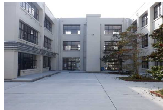
【工事が完了した柏原小学校の校庭】
