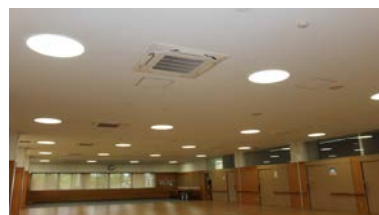
【照明LED化および空調改修工事】
