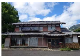
【市所有家屋解体工事前】
