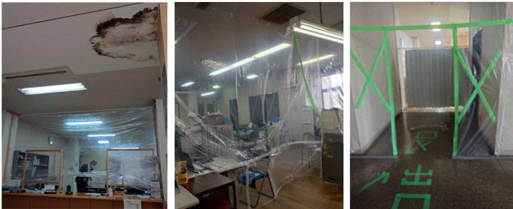
写真④ 施設の劣化状況（元議場と物置の雨漏り・天井の穴）
