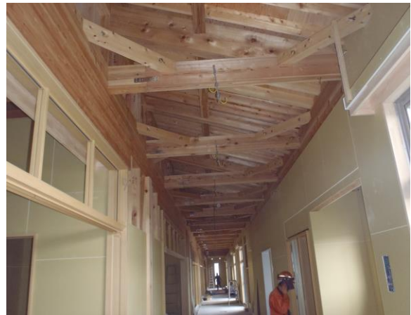
内部 廊下施工状況
