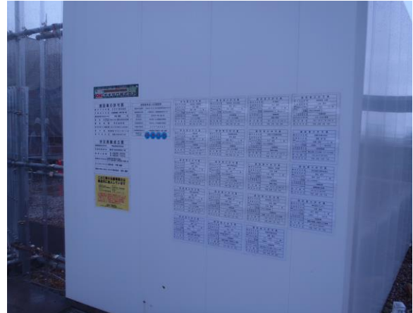
建設業許可標識、労災保険関係成立票、 建退共制度の適用標識
