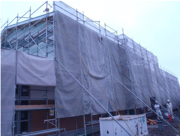
外部 北面施工状況
