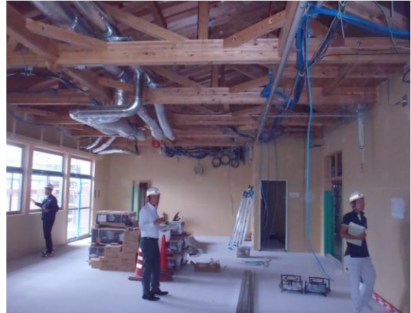
内部 職員室施工状況
