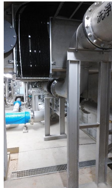
写真－７ 場内設備設置状況
