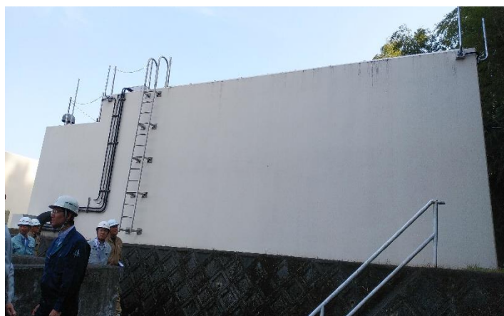
写真－3 工事現場施工状況
