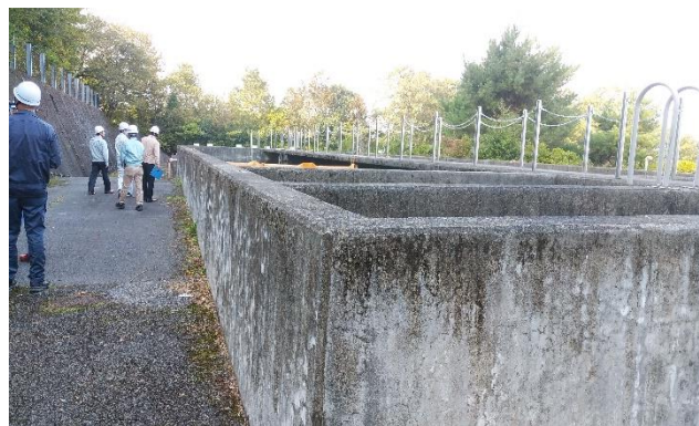
写真－2 工事現場状況②
