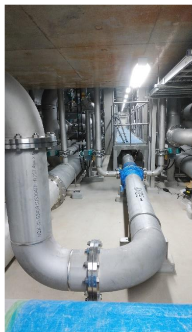
写真－4 場内配管状況
