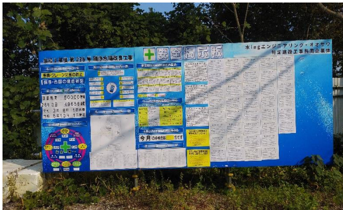
写真－６ 工事看板設置状況
