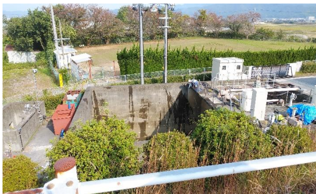
写真－1 工事現場状況①
