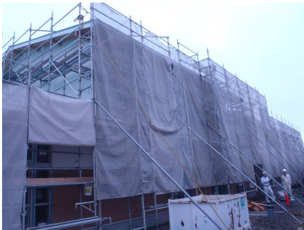
外部 北面施工状況
