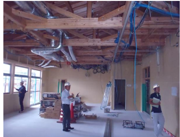
内部 職員室施工状況
