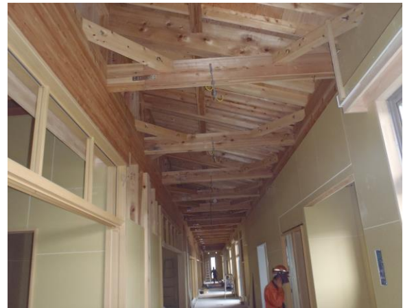
内部 廊下施工状況
