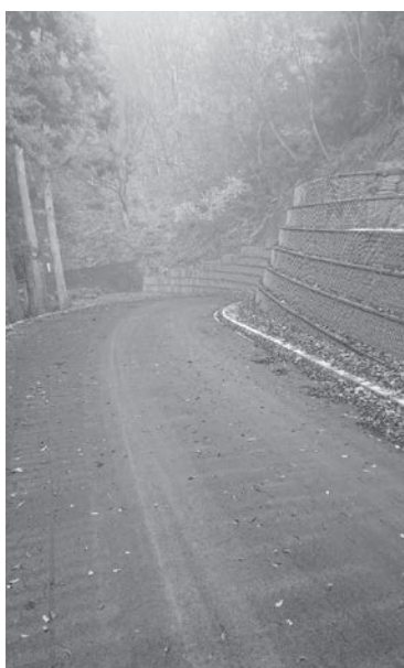
改良工事が進む林道西出大谷線
