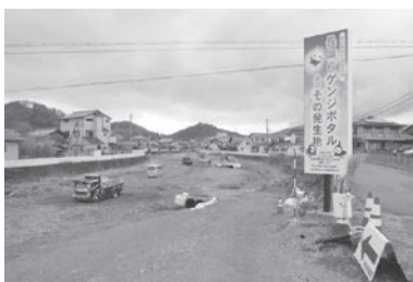
天野川の浚渫工事状況
