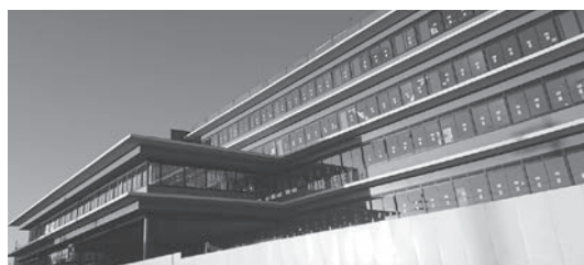
令和3年3月完成予定の市統合庁舎正面(令和2年12月4日現在)
