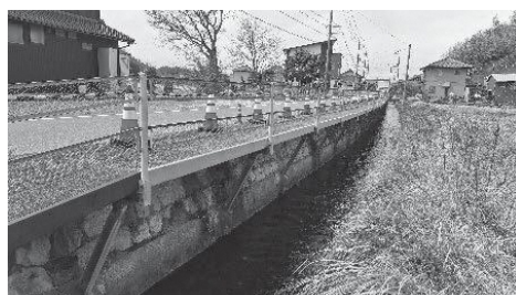
息長小学校西県道歩道工事予定箇所
