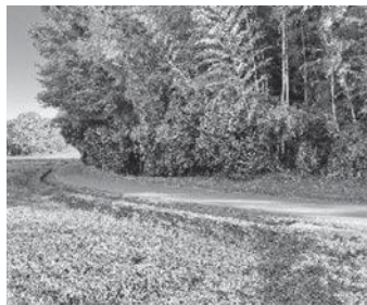
今にも竹やぶが倒れそうな仮通学路 (令和6年11月19日撮影)
