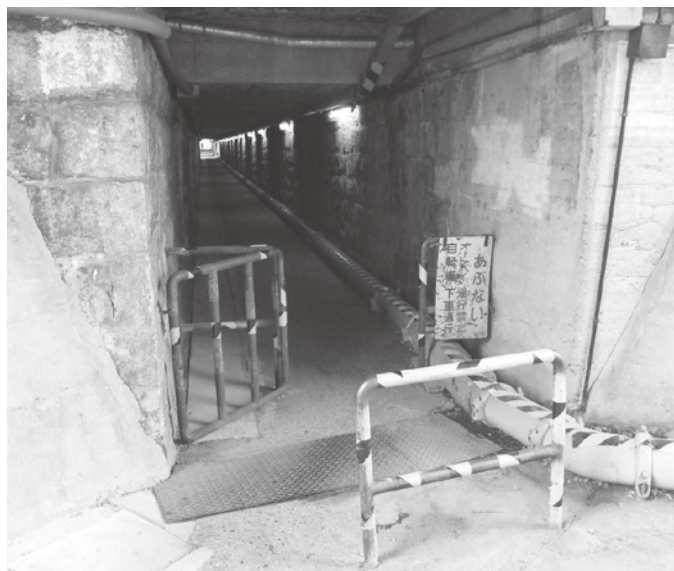
跨線橋下の東西通路
