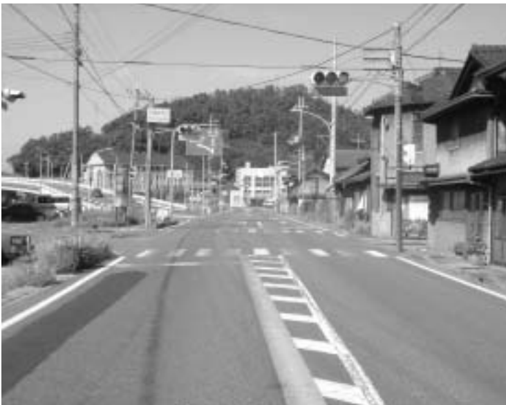
拡幅整備が始まる国道8号 (駅東幹線)
