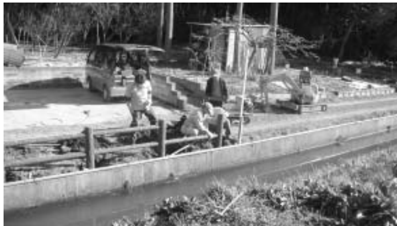
横堀川の転落防止柵
