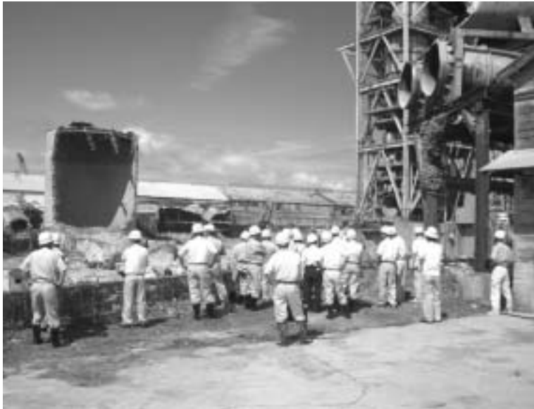
解体現場での現地説明
