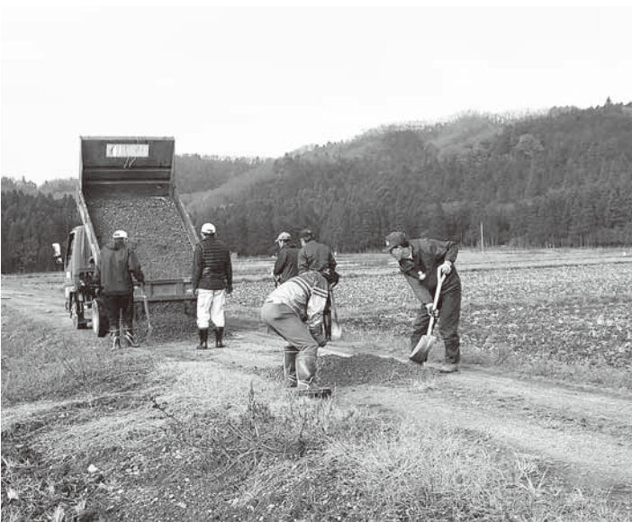
「世代をつなぐ農村まるごと保全向上対策」の農道補修作業
