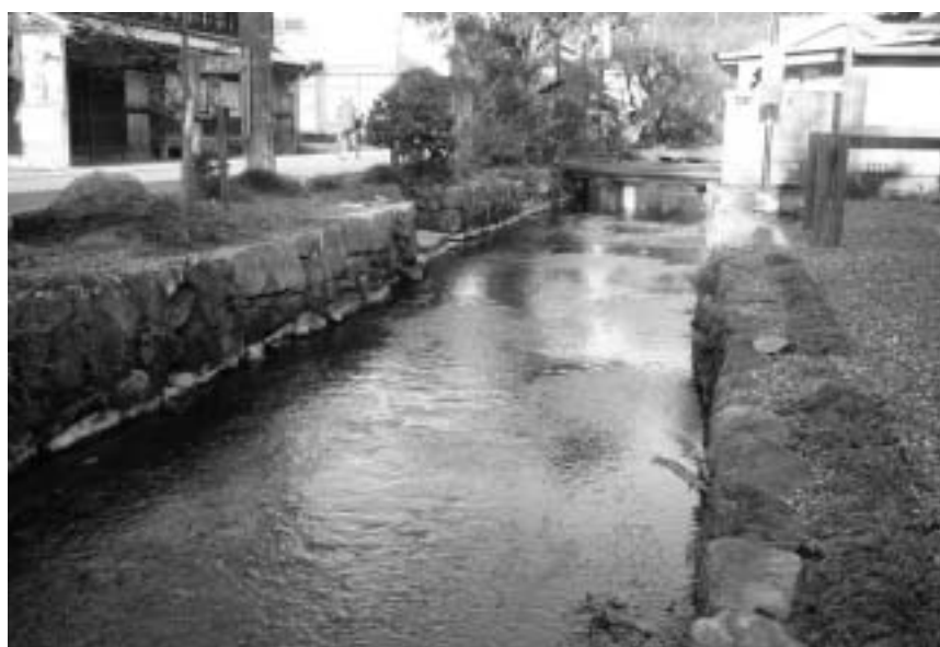
地蔵川の護岸状況
