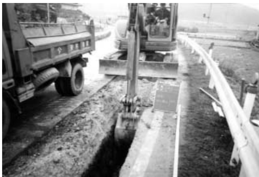
工事が進む管路工事
