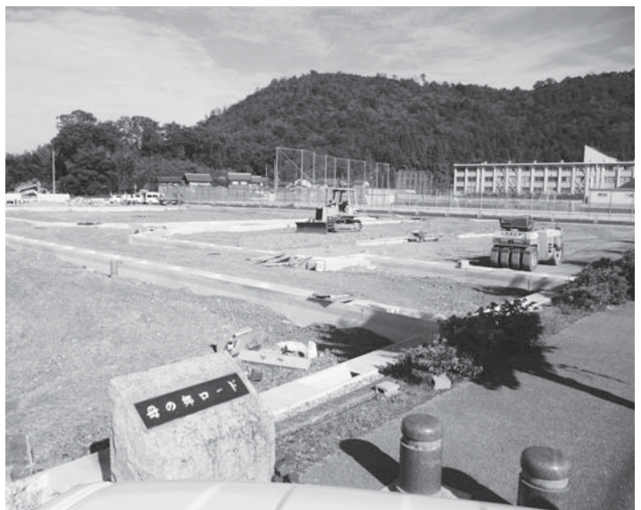
宅地造成中の顔戸琵琶田地区
