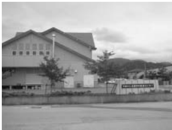
地盤が心配される米原学校給食センター
