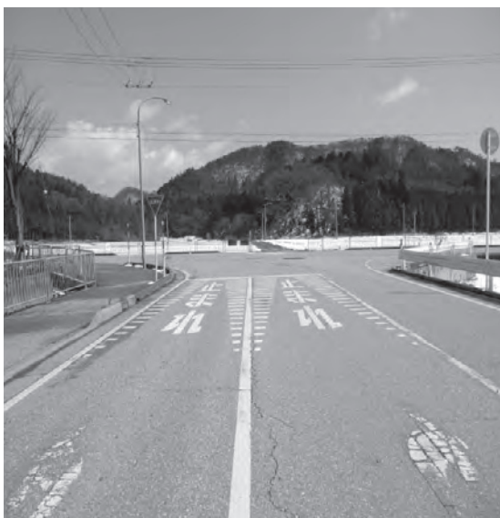
県道大鹿寺倉線と主要地方道山東一色線T字路交差点
