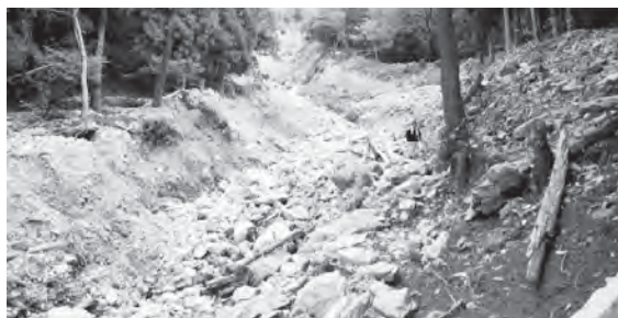
霊仙山の崩壊現場
