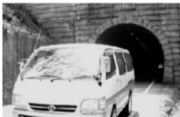
観音坂トンネル
