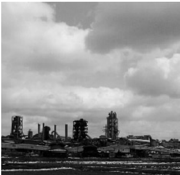
住友大阪セメント伊吹工場の現状
