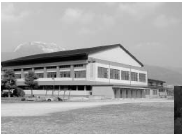
大東中学校体育館（完成後）
