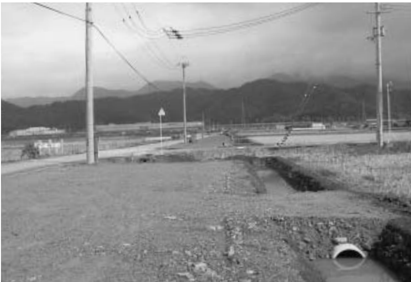
入江梅ヶ原線畦畔設置工事
