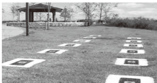
トイレ専用マンホール
