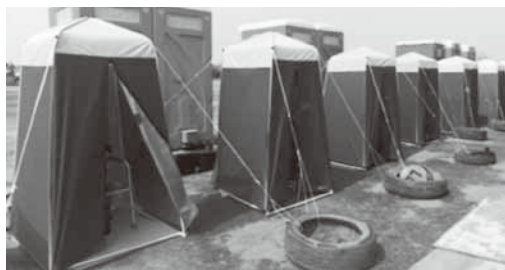
マンホールトイレの設置状況
