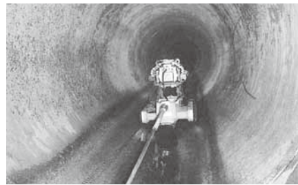
管路内をカメラで調査中
