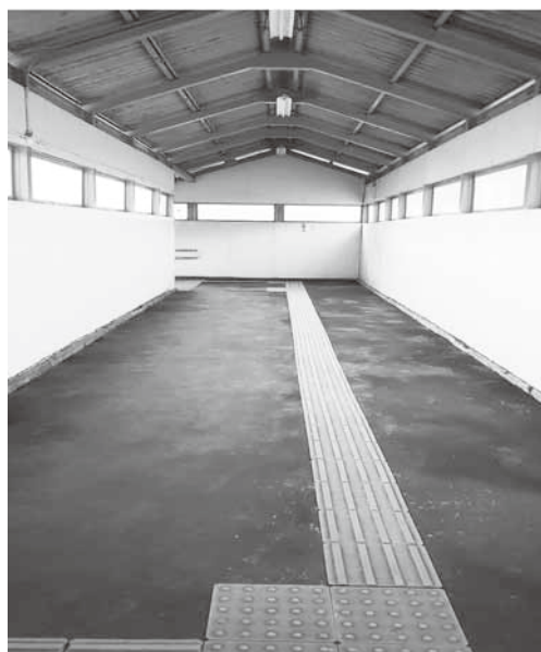
醒ヶ井駅の跨線橋部分
