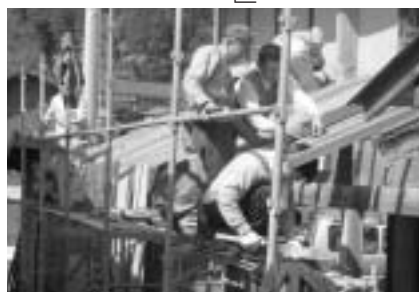
空き家の改修
