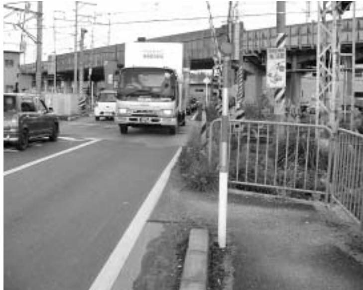
21年度着工か 拡幅に向けて動き始めた井戸町踏切
