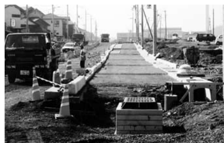
工事中の国道8号
