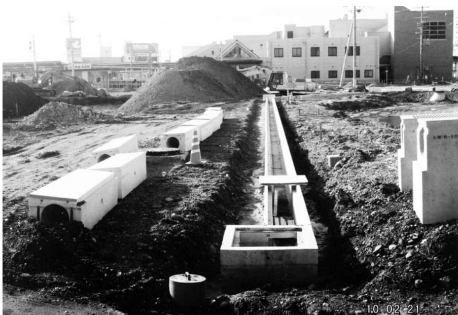
国道8号から駅前区画整理事現場を臨む
