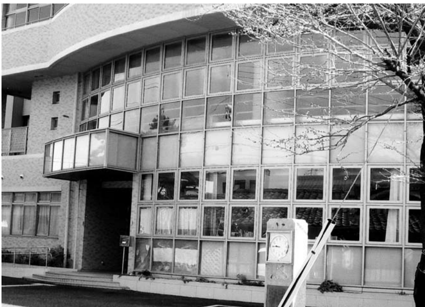
平成23年4月廃校予定の東小学校
