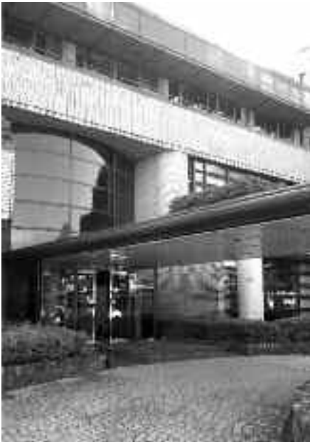
総合支所として活用予定の山東庁舎
