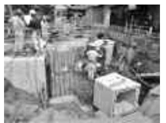
上流流入部の構造変更箇所(長岡地先)
