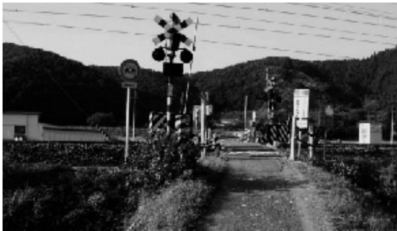
樋口・河南地先の狭隘な踏切
