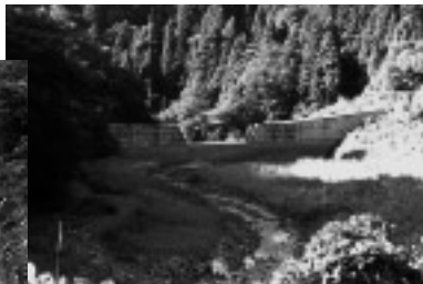
浚渫により貯砂機能、遊水機能を回復された堰堤
