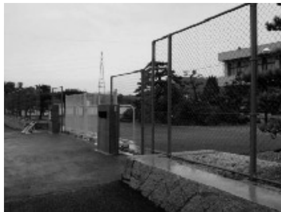
整備された学校フェンスと門扉
