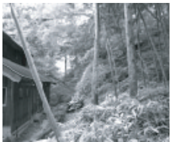
危険急傾斜地に隣接する民家（甲津原）
