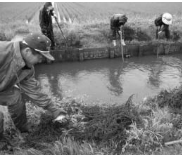
生き物にも配慮した水路の泥上げ作業
