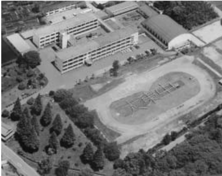
グラウンド改修が待たれる大東中学校
