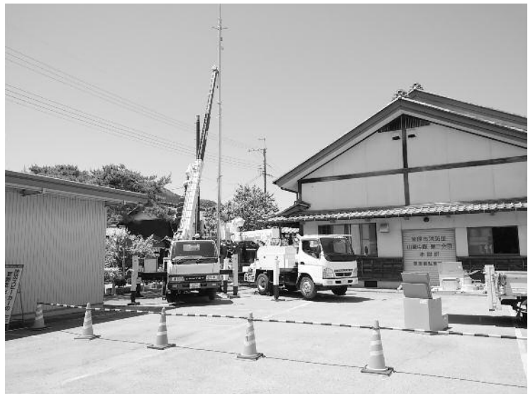
防災スピーカー設置工事
