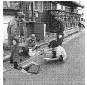
消防器具の点検
