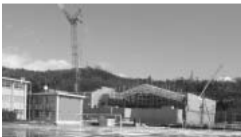
建設途中の米原市双葉総合体育館
