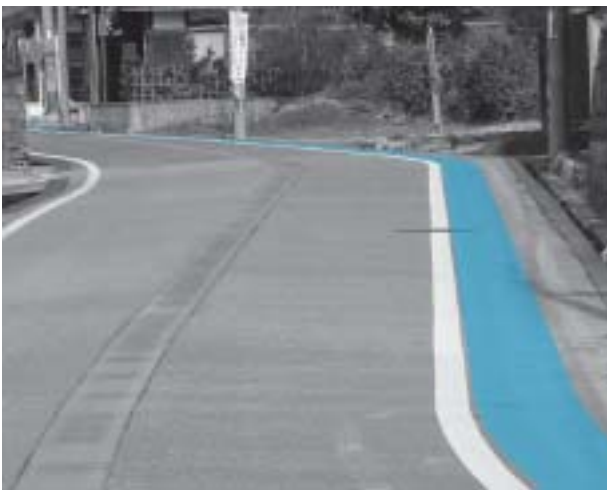
通学路に設置された「カラー区画線」
