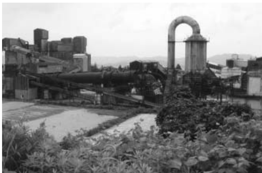
解体進む住友大阪セメント跡地
