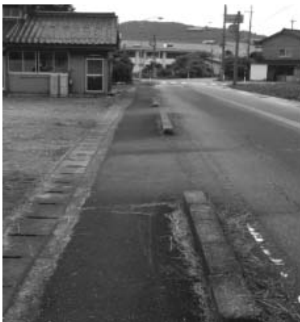
山東小学校の通学路になっている市道大鹿市場橋
