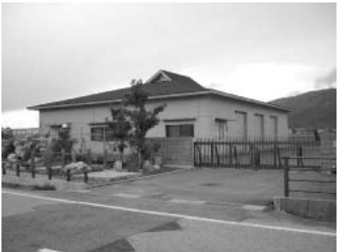
本市場浄水場（軟水化処理施設）
