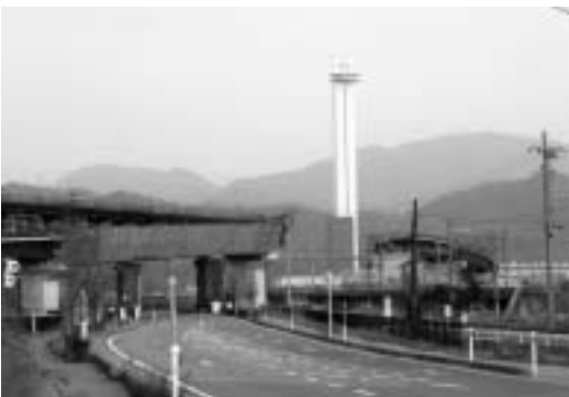
工事が進む南工業団地へのアクセス道路 (市道入江磯梅ヶ原線)
