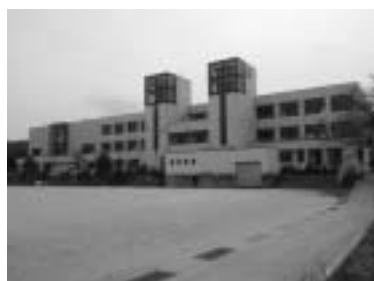
エレベーター設置される柏原小学校
