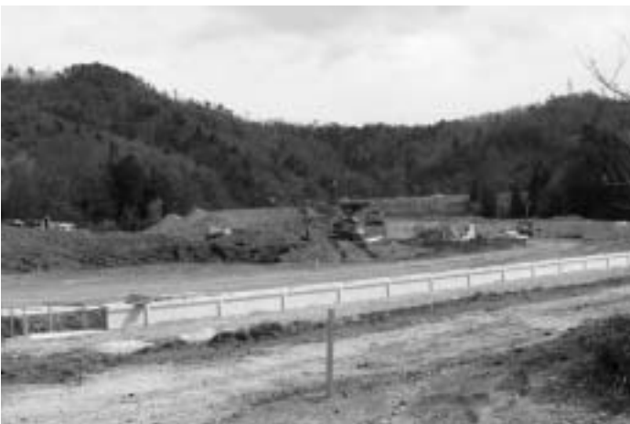
工事が進む(仮称)おうみ認定こども園建設現場
