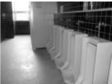
改修が待たれる学校のトイレ
