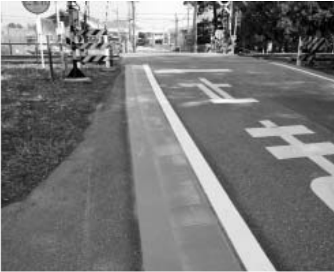
緑の舗装で通学路の安全対策
