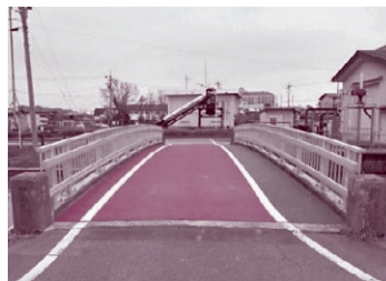
入江1号橋長寿命化工事
