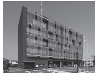
▲新消防庁舎の外観
