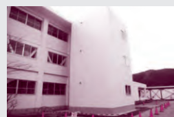
柏原中学校エレベーター設置工事
