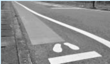
▲通学路の安全対策として、グリーンベルトを整備
