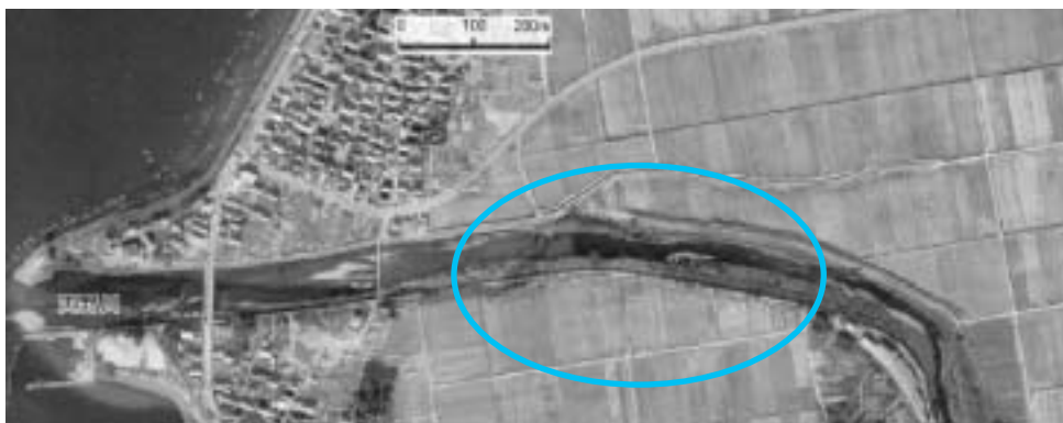
▲ 世継の霞堤（上空より）
