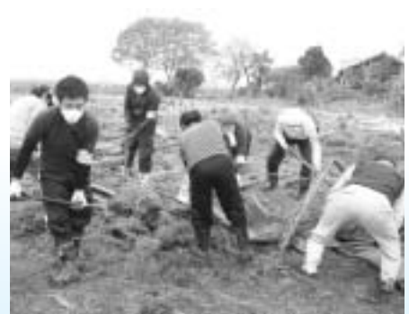
重機は田畑の復旧にまでまわらないため、人力に頼るしかない状況。水分を含んだ重いへドロをかき出しました。
