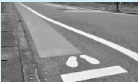
▲通学路の安全対策として、グリーンベルトを整備
