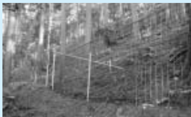
▲侵入防止柵の設置
