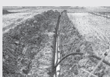
▲ほ場に排水管設置
