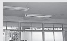
▲教室にエアコン設置
