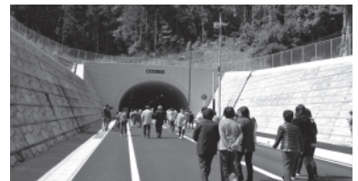
▲地元住民らによる渡り初め(米原市側)
