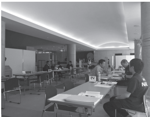
▲堀主査と久保主事が受付業務を行った、益城町文化会館。この建物も被災して天井が落ちているため、受付場所は安全なロビー。
