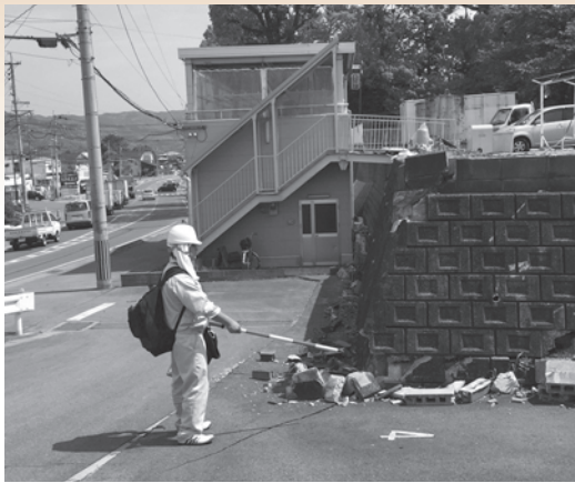
▲余震が続く中、益城町で被災宅地の危険度判定活動を行う吉田主事
