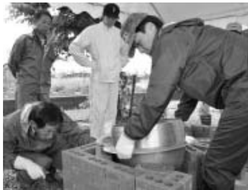
6月9日、世継会館で行われたレンガ積みの作業。能登瀬区役員の方も見学にこられ、情報交換が行われていました。
