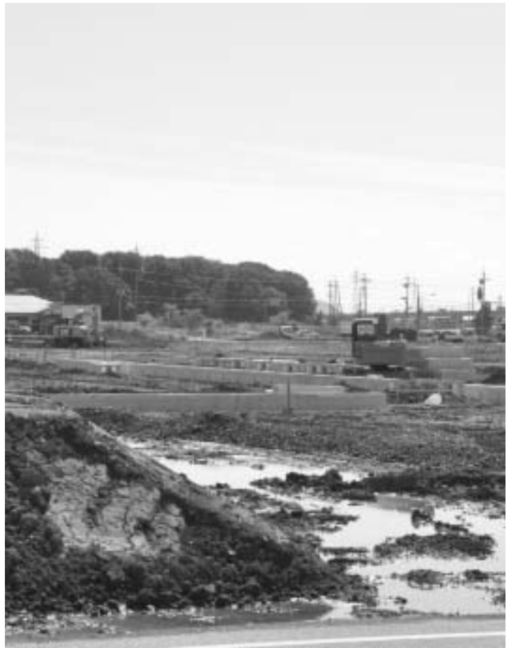
着々と工事が進む現場のようす
