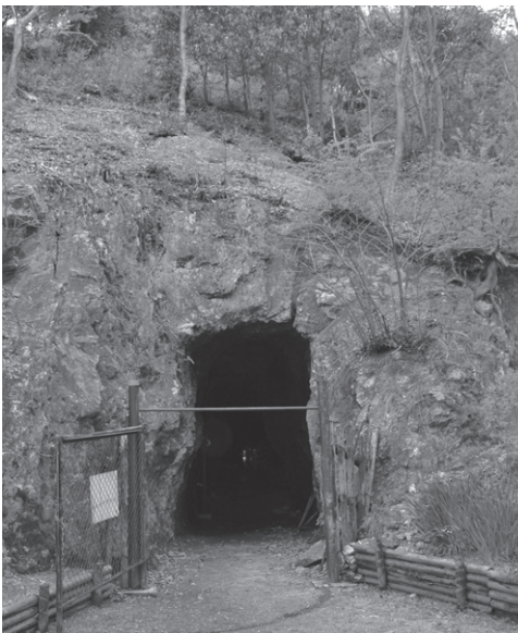
▲東側の避難壕入口
